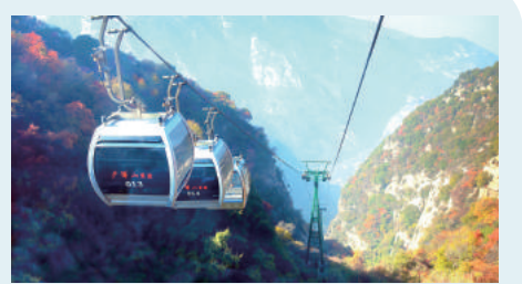
少华山索道：少华山索道全长1858米，垂直落差837米，索道全线运行设有17个支架，支架高度8—29米不等，吊厢距地面高度小于45米，索道运行速度为0.35—3.7米每秒，下站至上站运行时间约20分钟，方便快捷，全线设有8组吊厢，单方向每小时运输量可达400人，是目前西北地区最长最险的一条脉动式客运索道。目前，少华山第二条客运索道正在筹划建设中。
