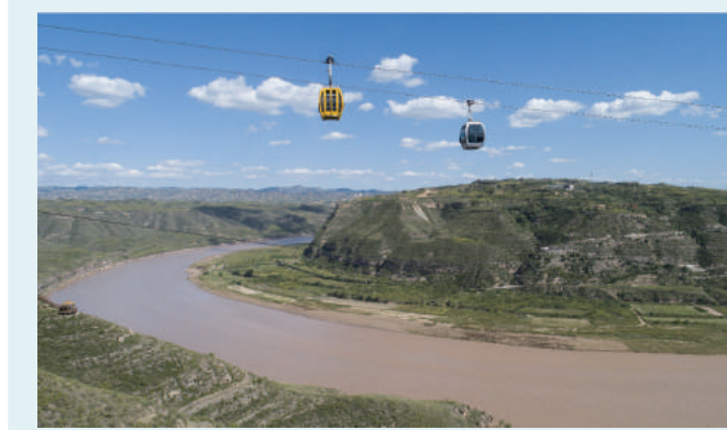
延川乾坤湾索道：乾坤湾索道分脱挂式和往复式索道，其中脱挂式索道线路为清水湾至会峰寨，索道类型为单线循环脱挂抱索器8人吊厢式，全长1900米，沿途共设有8个支架，上下站落差15米，运行速度可达到6米/秒，从清水湾乘坐索道到达会峰寨最快只需7分钟，单向运量可实现1500人/小时。清水湾至牛尾寨往复式索道全长840米，建成后预计最快6分钟可到达。
