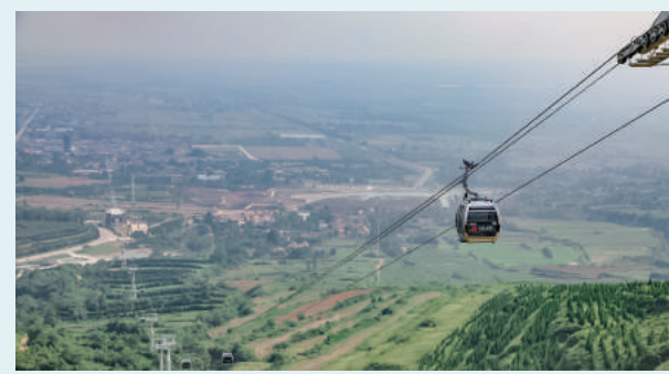
延川乾坤湾索道：乾坤湾索道分脱挂式和往复式索道，其中脱挂式索道线路为清水湾至会峰寨，索道类型为单线循环脱挂抱索器8人吊厢式，全长1900米，沿途共设有8个支架，上下站落差15米，运行速度可达到6米/秒，从清水湾乘坐索道到达会峰寨最快只需7分钟，单向运量可实现1500人/小时。清水湾至牛尾寨往复式索道全长840米，建成后预计最快6分钟可到达。
